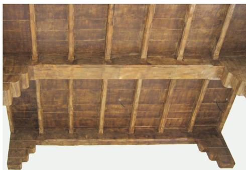
2. Particolare del soffitto in cemento armato al piano terra, tinteggiato a finto legno. (F. Coluzzi)
