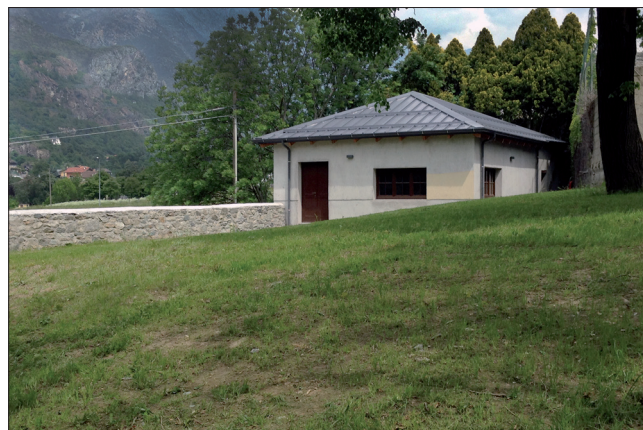
2. L'edificio "ex tennis" al termine dei lavori di riqualificazione. (F. Coluzzi)
